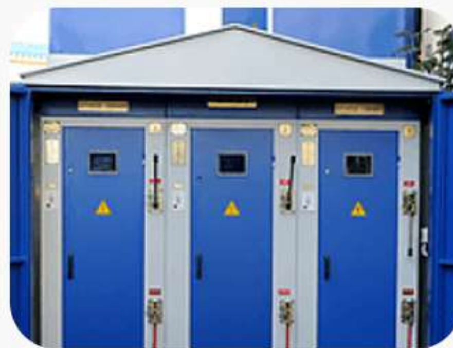
Трансформаторы (ТОО "УТЗ")
